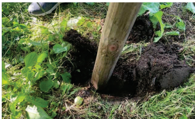
写真9 支柱下部のズレ防止
