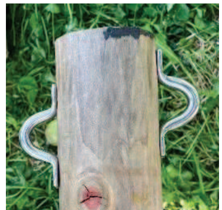
写真8 フックの取付け例
