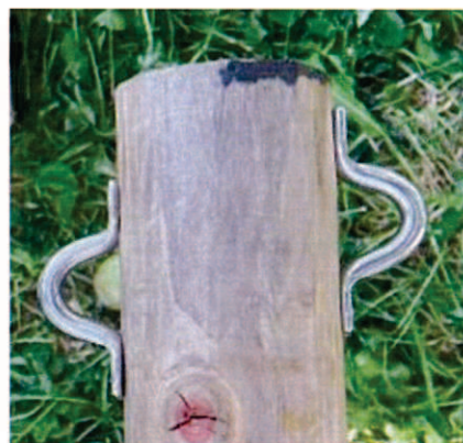
写真8 フックの取付け例
