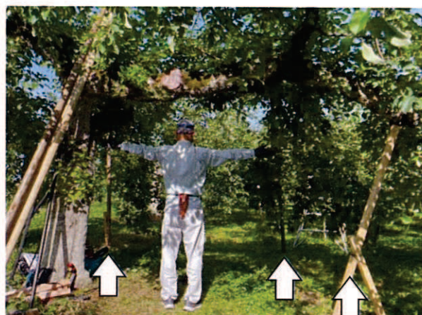
写真6 SS 走路の確保 (矢印: 支柱位置)
