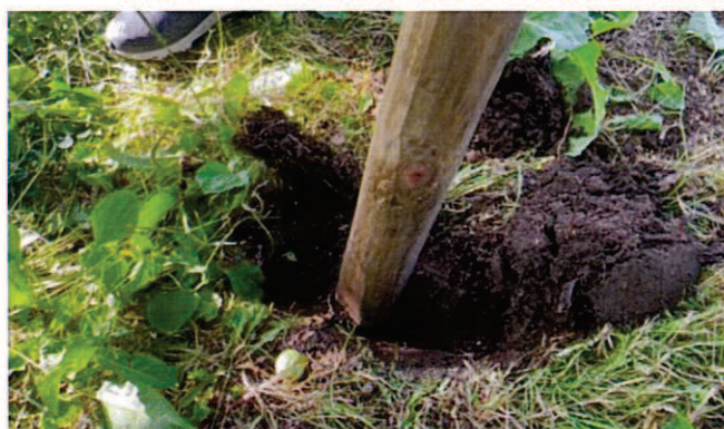
写真9 支柱下部のズレ防止
