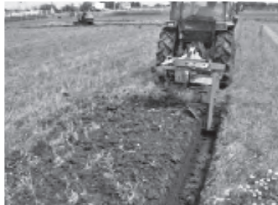
写真1 スクリューオーガーによる額縁排水
