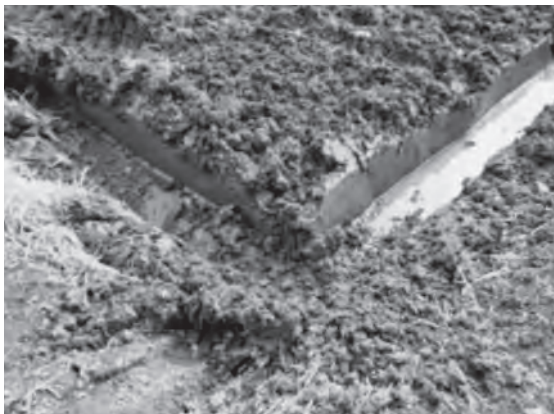
写真2 連結部の手直し溝の深さを一定とする
