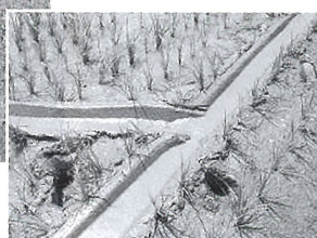
溝の連結、水尻へのつなぎを忘れずに！
