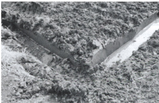
溝の深さが一定となるようにする 連結部を掘り下げる
