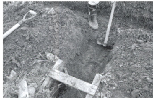
溝と水尻を連結するために掘り下げる
